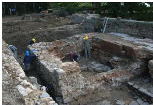
Le chauffeoir de la brasserie du 18 e s. de Cambron, avec au centre les vestiges du fourneau. Photo D. Ingels © SPW AWaP
